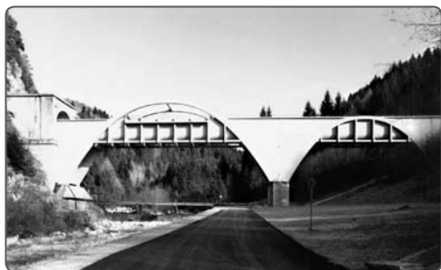
Ponte canale sul Sarca di Campiglio
