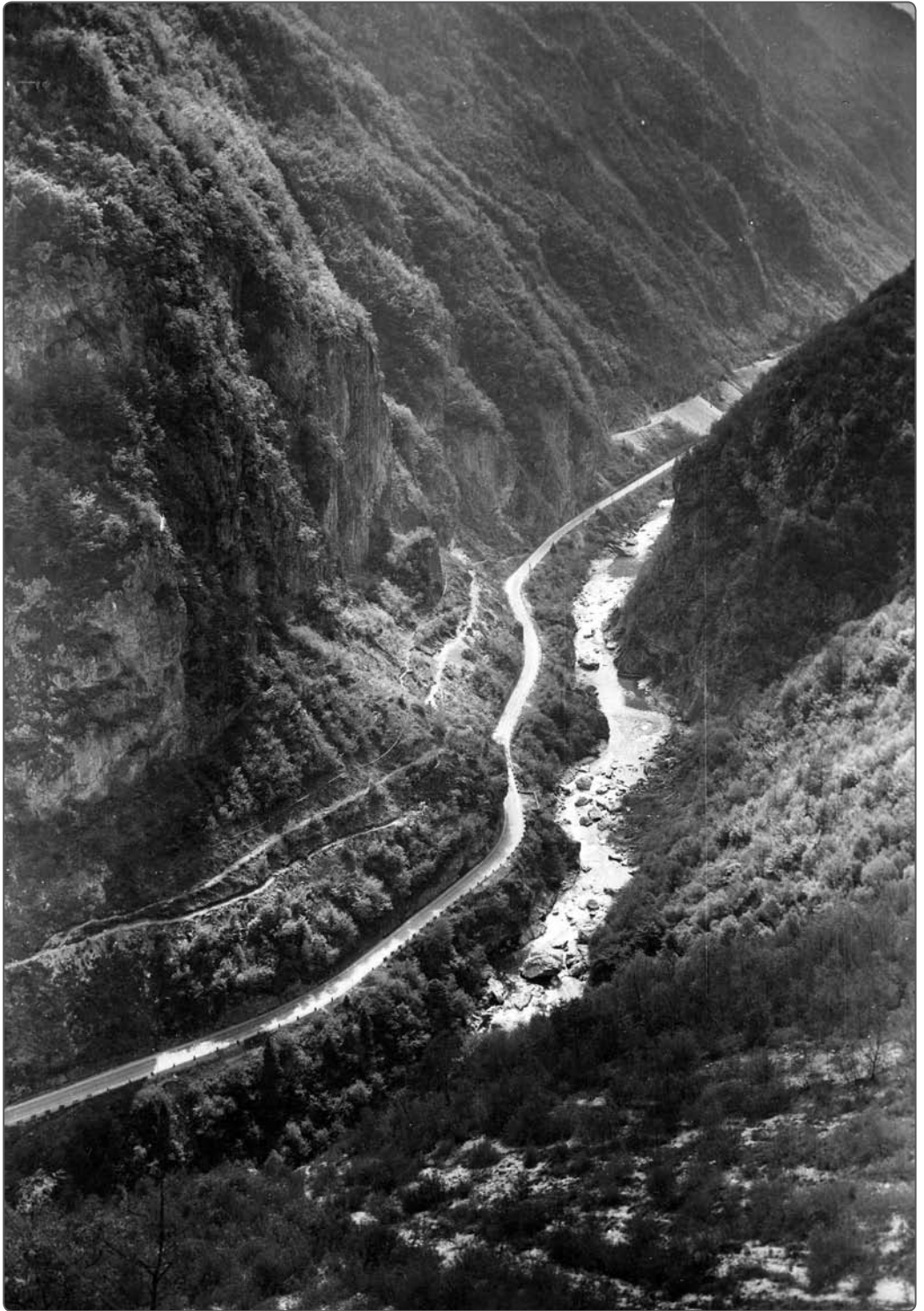
Maggio 1954. Panoramica dal Doss de la Scala. La vecchia strada della Scaletta ed il tracciolino della nuova variante tra le progressive 1700 e 2500
