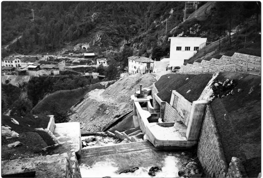
Sopra: maggio 1955. Veduta generale del cantiere di Ponte Pià con la casa degli uffici tuttora esistente Sotto: luglio 1956. Cantiere di Ponte Pià. Veduta generale a lavori in via di ultimazione
