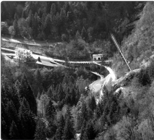
Dalla Val dei Molini veduta su Ponte Pià, si noti la parte terminale della condotta di Val Marcia
