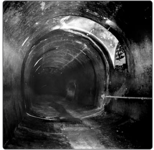
La galleria di derivazione a sez. policentrica in corrispondenza del Rio Flanginech a Giustino
