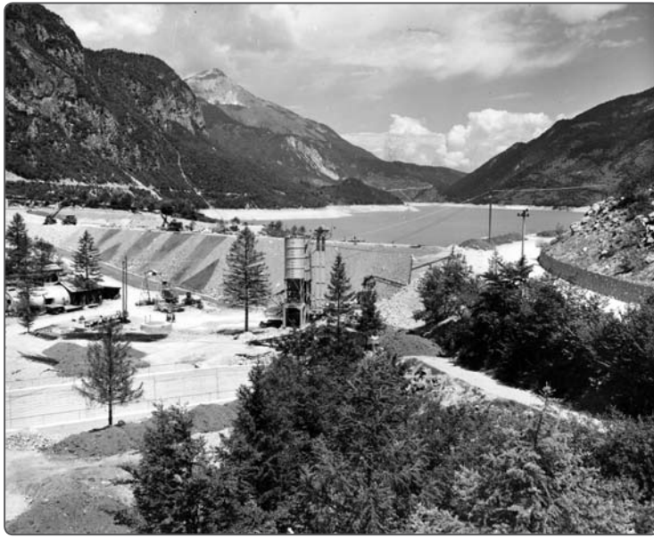
1962. Costruzione della diga per l'innalzamento a quota 825 del livello del lago. La diga fu in seguito demolita per le decise opposizioni al progetto
