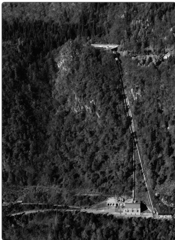
La centrale alla Rocca di Breguzzo. In alto si nota la vasca di carico della Rocchetta congiunta alla centrale con le condotte forzate
