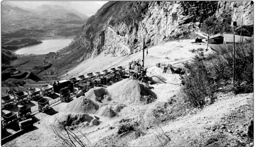
Il cantiere presso la finestra Gaggi poco sopra la strada che porta a Ranzo. Sullo sfondo il lago di S. Massenza
