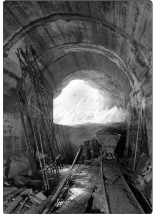
Sopra: giugno 1956. Cantiere di Ponte Pià. Galleria di derivazione a Santa Massenza. Casseri metallici per il getto di rivestimento della galleria
